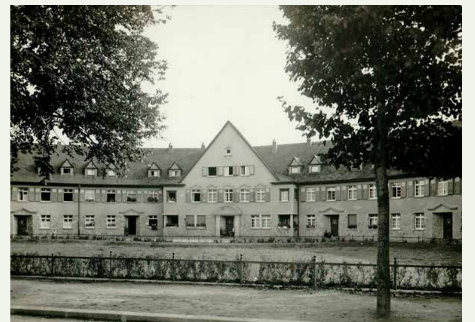
Städtische Siedlung am Völkerring in Bad Kreuznach, 1924 errichtet, um 1943/44 (Stadtarchiv Bad Kreuznach, 6.20-1110)
